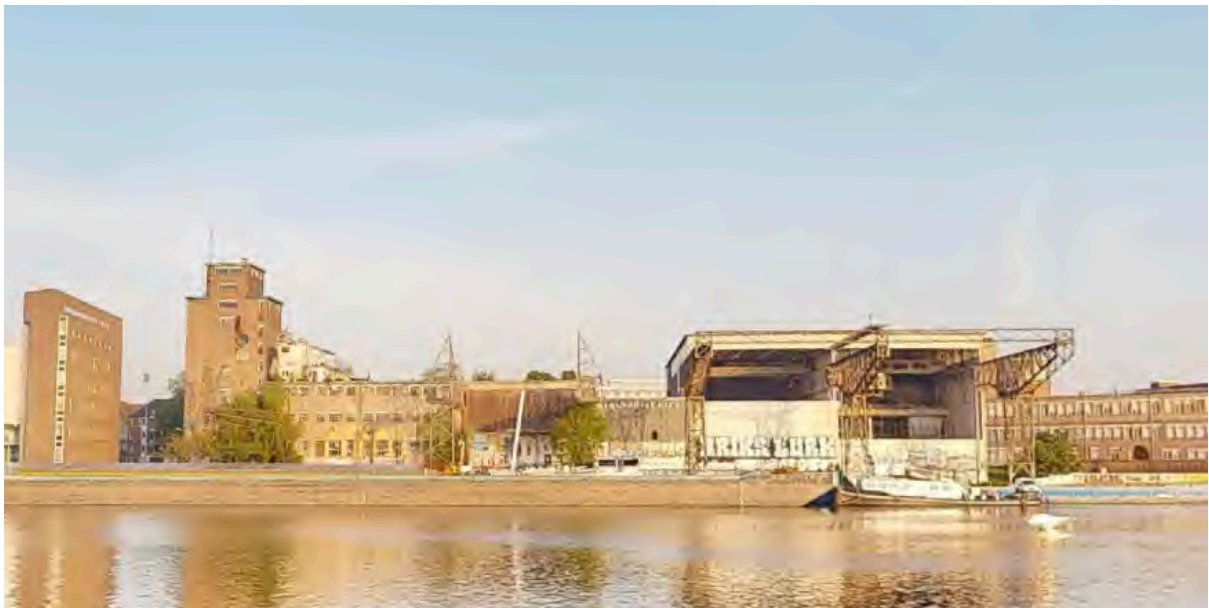
Aanzicht van het Landbouwbelang vanaf het Griendpark aan de andere zijde van de Maas. De toren van het silogebouw is een markant punt in de contour van het complex. vanwege de oriëntatie op de Maas als waterweg voor de industrie opent het ensemble zich als gevelfront naar de rivier. Afbeelding: Google Maps.
