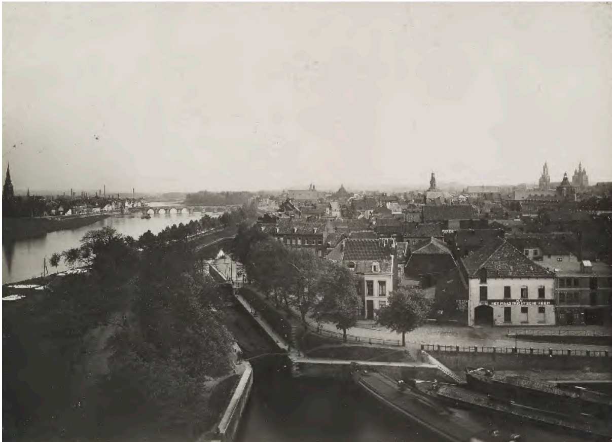
1910, foto in zuidelijke richting met op de voorgrond het Bassin en de sluis die toegang biedt tot het Kanaal Luik-Maastricht. Links op de foto rivier de Maas. De twee sluiswachterswoningen langs de Maasmolendijk 24 en 26 werden in 1869 gebouwd en stonden in relatie tot deze sluis. Nummer 24 werd in 1909 uitgebreid en met een verdieping verhoogd. Afbeelding: Beeldbank RCE, inv.nr. 20324889.
