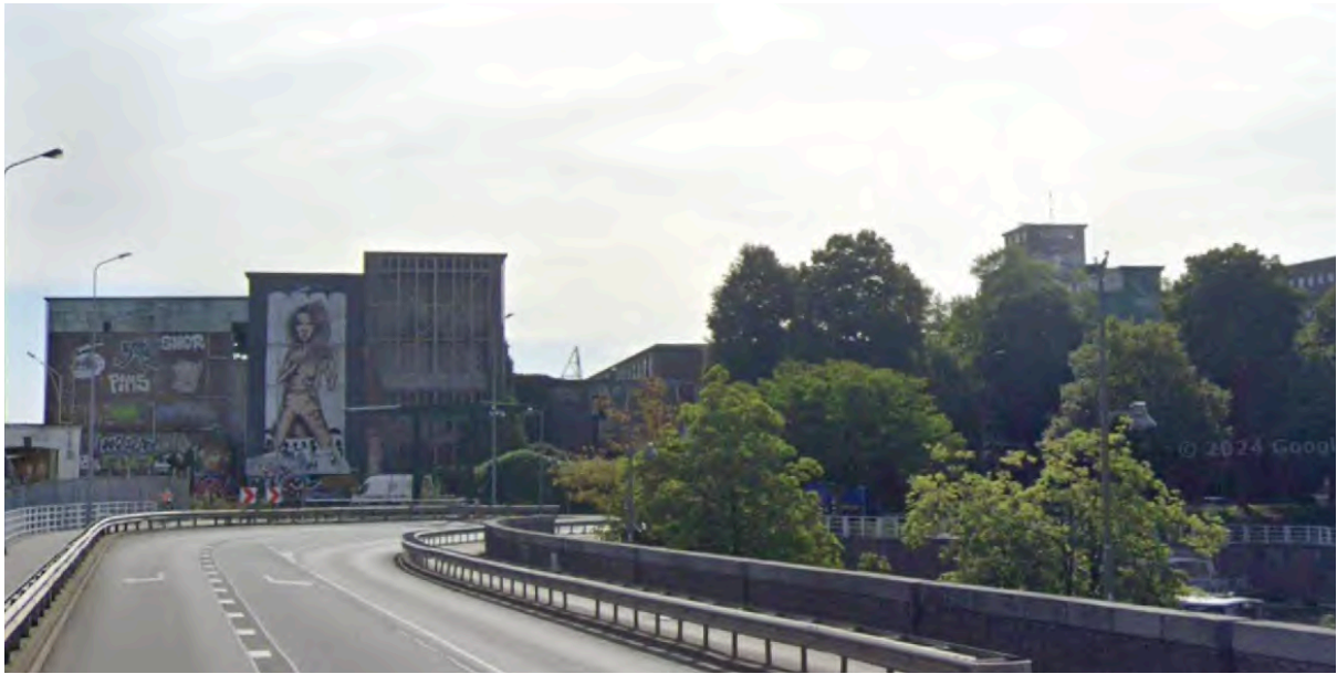
Zicht op het Landbouwbelang vanaf de Maasboulevard nabij het Bassin. Het bouwdeel aan de linkerkant van het complex betreft het kleiverwerkingsgebouw, de oudere complexonderdelen bevinden zich rechts daarvan. Door de bestaande infrastructuur is het industriële ensemble van het Landbouwbelang niet aangetakt op het stedelijke gebied. Rechts op de achtergrond de toren van het silogebouw. Afbeelding: Google Maps.
